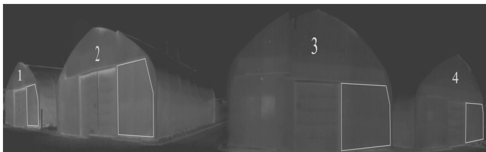
Rysunek 1. Termogram panoramiczny ścian szczytowych tuneli z zaznaczonymi obszarami pomiarowymi (zdjęcie panoramiczne w odległości 6 m od tuneli) Figure 1. A panoramic thermal image of the gable ends of tunnels with marked measurement areas (panoramic image at the distance 6 m from tunnels)
