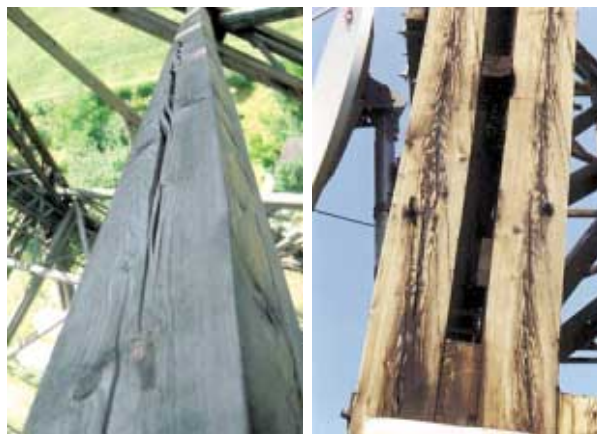
Rys. 4. Spękania podłużne prętów
