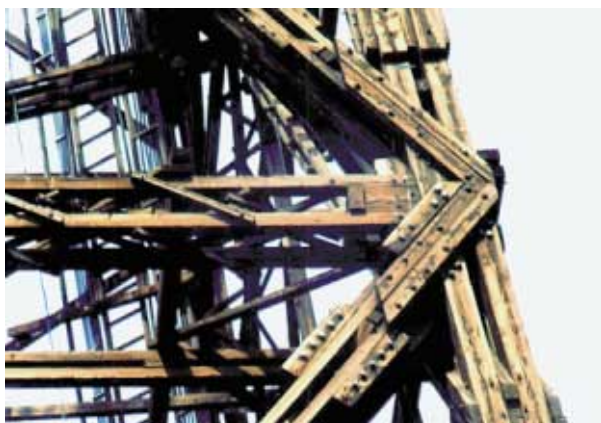
Rys. 1. Widok ogólny wieży oraz szczegóły konstrukcji
