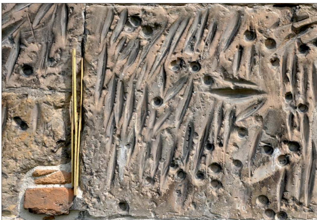
Ryc. 13. Półkuliste i wydłużone żłobienia w ciosie piaskowcowym z muru kolegiaty w Opatowie Fig. 13. Hemispherical holes and elongated grooves in a wall of the collegiate church in Opatów
