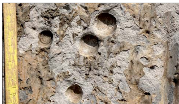
Ryc. 12. Półkuliste zagłębienia w murze kolegiaty w Opatowie, o wygładzonych i zarysowanych wewnętrznych powierzchniach Fig. 12. Hemispherical holes in a wall of the collegiate church in Opatów. Inner surfaces are scratched or polished
