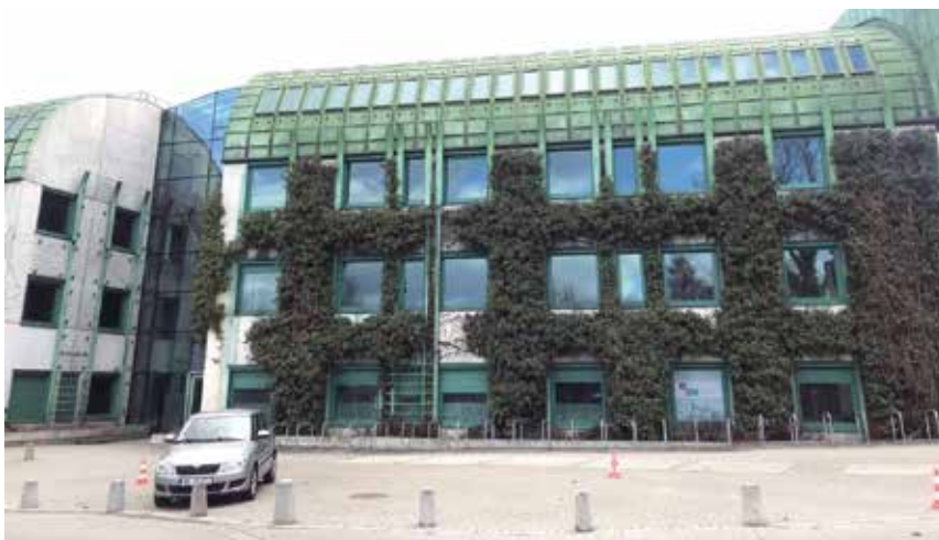
Fot. 4. Oryginalna zielona ściana elewacji wraz z roślinnością przy budynku Biblioteki Uniwersytetu Warszawskiego (2021); źródło: fot. autor
