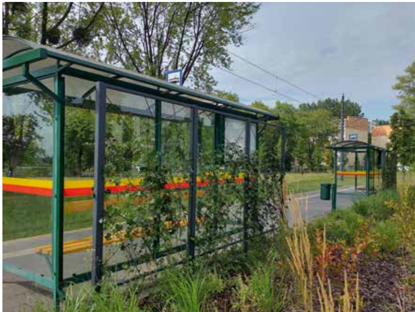
Fot. 5. Nowo powstałe tzw. zielone przystanki w Łodzi, ściana z pnączami (2023); źródło: fot. autor
