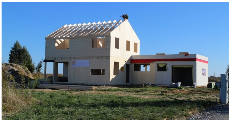
Rys. 1. Dom jednorodzinny w Jakubowicach Konińskich pod Lublinem (w trakcie realizacji) [fot. własna]
