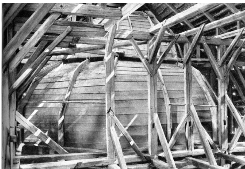
Ryc. 7. Fragment konstrukcji dachu i kopuły synagogi w Końskich.
