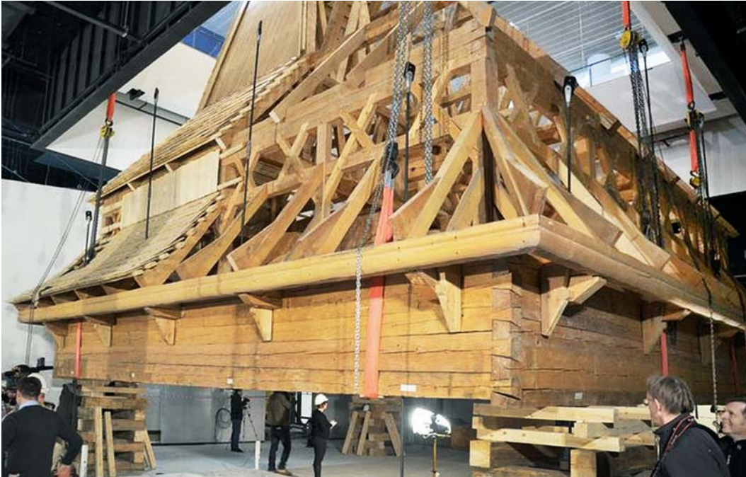
Ryc. 11. Muzeum Żydów Polskich POLIN – rekonstrukcja dachu sali głównej synagogi w Gwoźdźcu. Źródło: [8] Fig. 11. The Museum of the History of Polish Jews POLIN in Warsaw – reconstruction of the wooden roof construction of the main prayer room of the synagogue in Gwoździec. Source: [8]
