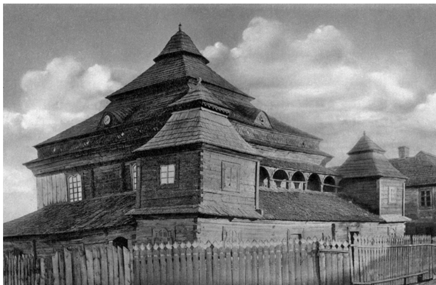
Ryc. 5. Widok drewnianej synagogi w Śniadowie – fot. sprzed 1938 r. Źródło: [3]
