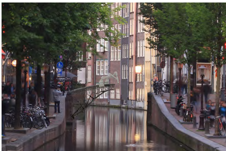
Rys. 11. Stalowa kładka w Amsterdamie [12]
