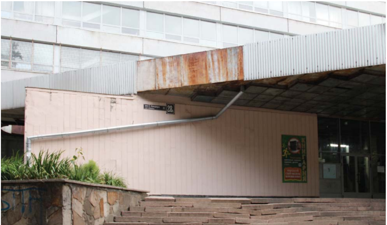
II. 1. Strefa wejściowa do budynku nr 5 Politechniki Lwowskiej przy ulicy Stepana Bandery 28a — dawna ulica Leona Sapichy (fot. Maciej Złowodzki).
