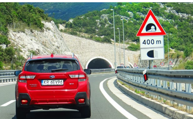
Tunel drogowy na autostradzie Zagrzeb – Split, fot. A. Olszewska
