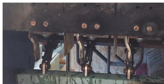
Fot. 1. Ślady działania wysokich temperatur w polu zasilającym dławik
