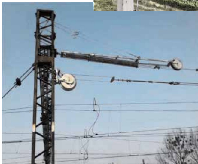
Rys. 7. Sprężynowe urządzenia naprężające [21]
