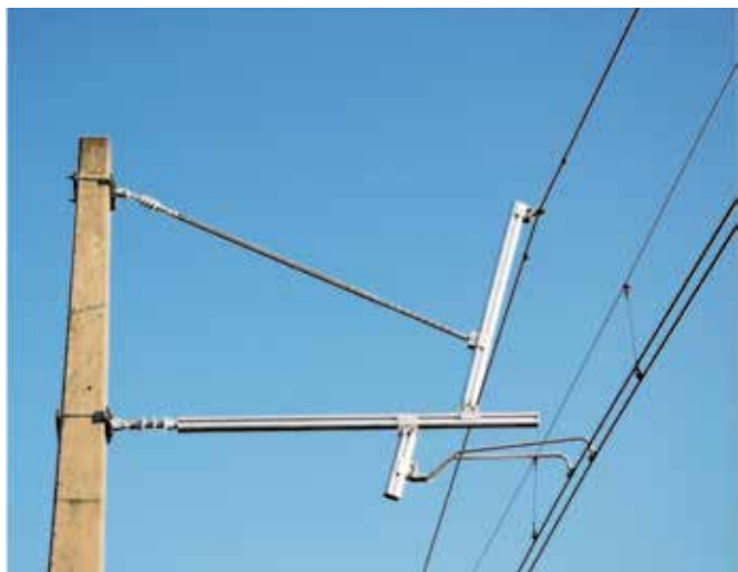
Rys. 6. Pilotażowe rozwiązanie podwieszenia sieci trakcyjnej [19]
