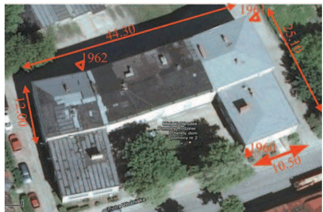
Rys. 1. Widok analizowanego budynku z lotu ptaka
