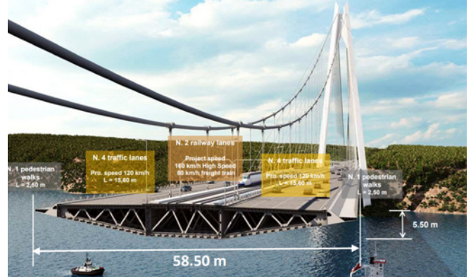
Graficzna ilustracja przekroju mostu Selima Groźnego, fot. [23]
