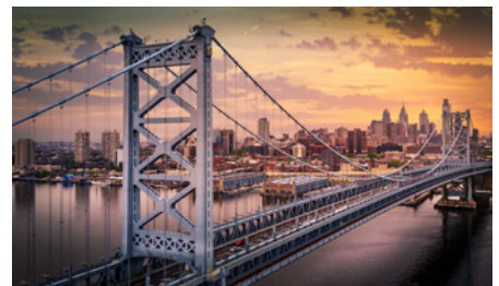
Most Benamina Franklina z przejeżdżającą kolejką podmiejską, fot. Jin, Adobe Stock
