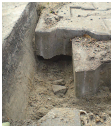
Rys. 4. Zakleszczony chodnik nad osiadającym podłożem w obszarze wyspy między wagami
