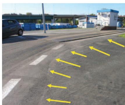
Rys. 6. Krawężnik wykonanych napraw drogi
