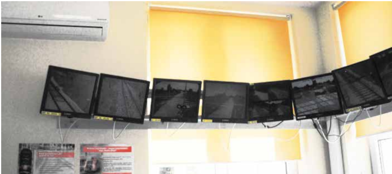
Przykład rozmieszczenia monitorów na niewielkiej stacji, gdzie chaotycznie rozmieszczonych monitorów jest ponad 20
