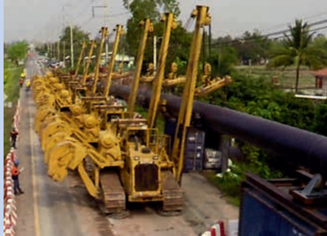
Ryc. 2. Gazociąg o długości 720 m wciągany pod jedną z ulic podczas FTP2 [1, s. 53]
