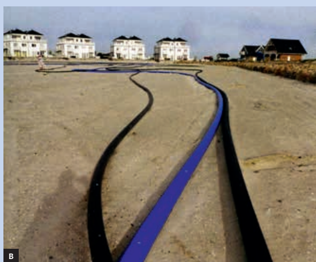
Ryc. 3. Horyzontalny przewiert sterowany u wybrzeży Bałtyku: A – widok wbudowanego rurociągu, B – przewody polietylenowe przygotowane do wciągania [1, s. 50–51]
