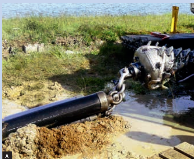
Ryc. 2. Gazociąg o długości 720 m wciągany pod jedną z ulic podczas FTP2 [1, s. 53]
