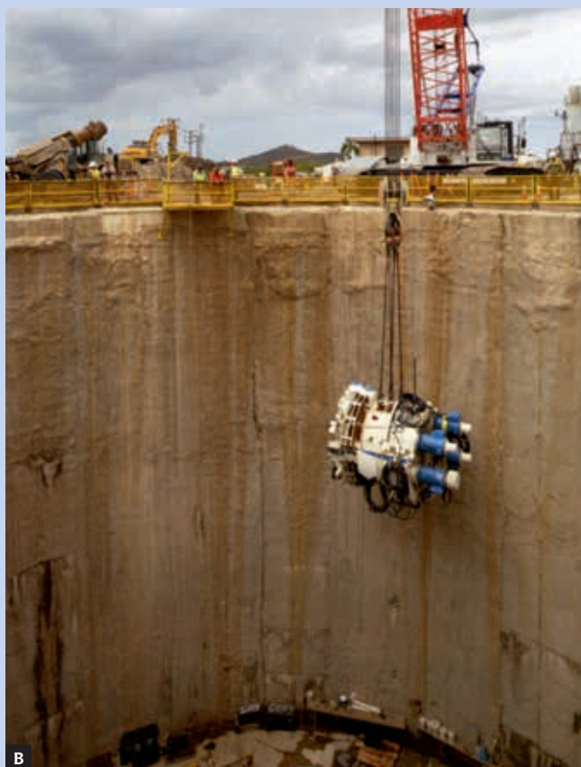
Ryc. 4. Tunelowanie na Hawajach: A – element tarczy TBM, B – element TBM opuszczany do komory startowej [1, s. 45]
