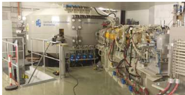
Fot. 6. Cyklotron Proteus C-235 (fot. z arch. IFJ) Photo 6. Cyclotron Proteus C-235
