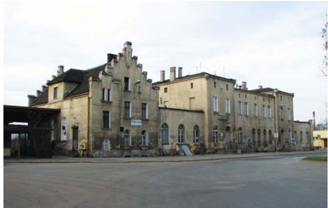
Fot. 3. Budynek dworca Dzierżoniów Śląski wyglądem z zewnątrz nie zdradza prężnie funkcjonującego wewnątrz baru; jedynym jego wyróżnikiem jest niewielka tablica reklamowa widoczna poniżej okien pierwszego piętra (22.11.2009 r.). Fot. T. Korycki
