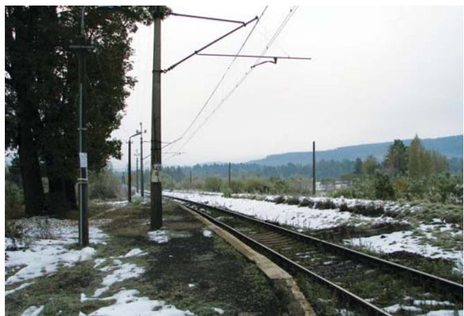
Fot. 5. Po wyburzeniu murowanego budynku na przystanku Kwieciszowice (znajdował się po lewej stronie, gdzie pozostałości przykryte są śniegiem) brakuje jakiegokolwiek schronienia dla pasażerów. Charakterystyczne dla Śląskiej Kolei Górskiej niewielkie budyneczki dworcowe (lub ich zrujnowane pozostałości) podziwiać wówczas można było jeszcze na kilku innych przystankach, m.in. Ciechanowice i Ubocze, który już w 2009 r. przeznaczony był do rozbiórki (20.10.2009 r.). Fot. T. Korycki
