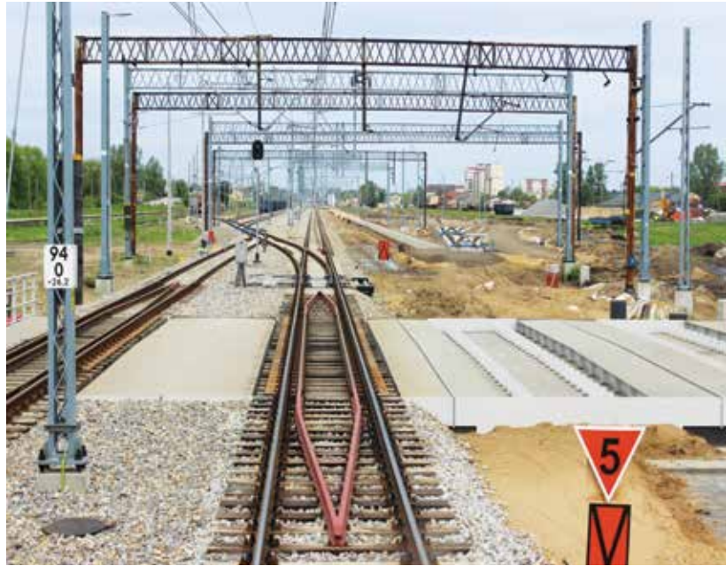
Przebudowa stacji Siedlce na linii E20. Fot. A. Massel
