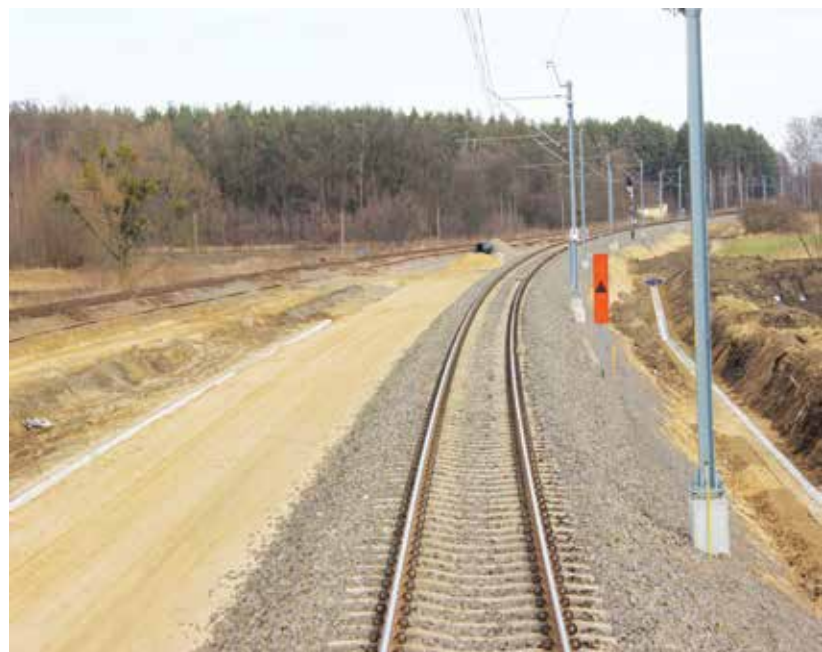
Przebudowany tuki na linii E59 w rejonie stacji Skokowa
