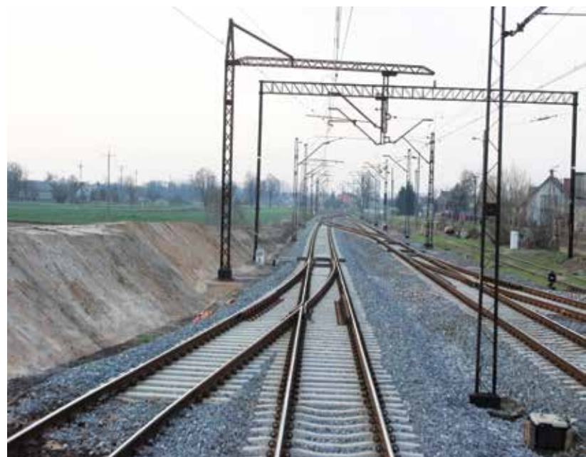
Nowe rozjazdy na stacji Babiak na Magistrali Węglowej. Fot. A. Massel
