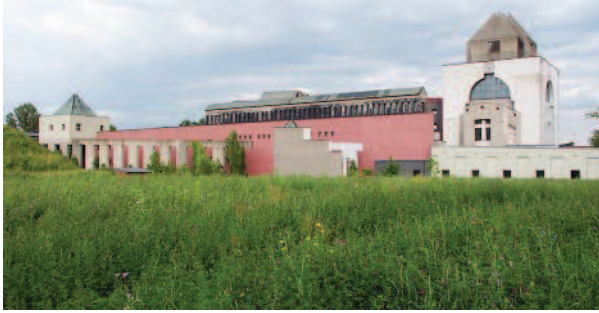
Wyższe Seminarium Duchowne Zmartwychwstańców na Zakrzówku (arch. D. Kozłowski i W. Stefański, 1985-1993)
