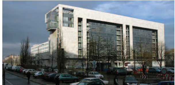
Nowe skrzydło Sądu Okręgowego i Sądów Rejonowych (arch. W. Obtulowicz, 1997-2001)
