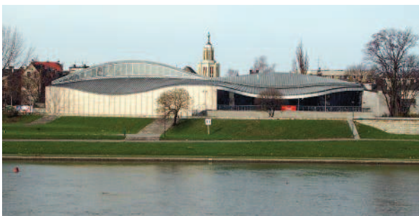
Centrum Sztuki i Techniki Japońskiej „Manggha” (arch. A. Isozaki, K. Ingarden, 1993-1994)
