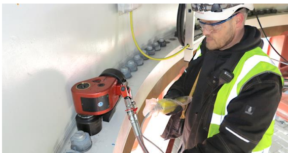
Rys.2. Montaż połączenia kotłierowego turbiny wiatrowej [3]
