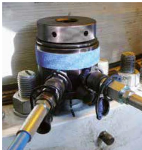
Rys.4. Montaż połączenia śrubowego turbiny wiatrowej z wykorzystaniem napinacza hydraulicznego [5]
