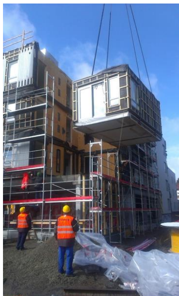
Rys. 4. Budynki drewniane modułowe (Źródło: Unihouse): a) w technologii szkieletu drewnianego, b) w trakcie budowy
