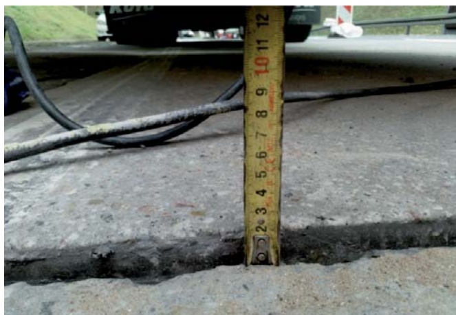
Fot. 2. Stabilizacja i podniesienie płyty betonowej nawierzchniowej przed i po wykonaniu iniekcji, droga krajowa nr 50 – Obwodnica Młodzieszyzna
