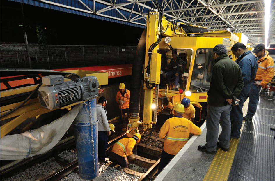
Rys. 7. VM 170 M Jumbo podczas wymiany podsypki na stacji Patriarca [5]
