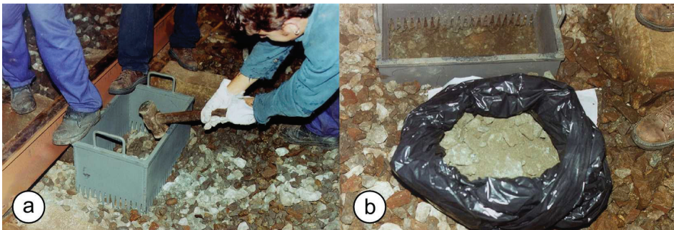
Rys. 4. Pobieranie próbek podsypki na linii 3 Vermelha. a) — wbijanie skrzyni w miejsce pobrania próbki; b) — pobrana próbka podsypki [5]
