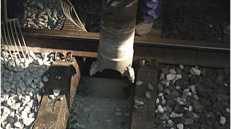
Rys. 6. Pazury do mechanicznego zruszania podsypki umieszczone na wlocie przewodu ssącego maszyny VM 170 M Jumbo [5]
