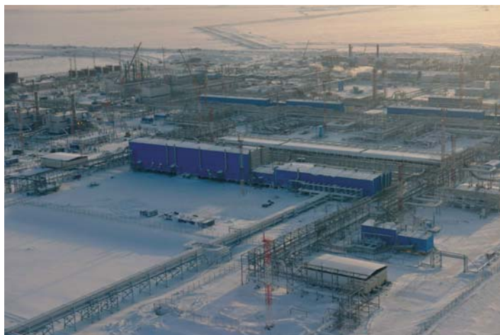
Kompleks wydobywczo-przesyłowy gazu ziemnego Bowanienkowo w zimie, pomimo mrozów rzędu –50–60°C, całość musi funkcjonować perfekcyjnie (28.02.2012 r.)
