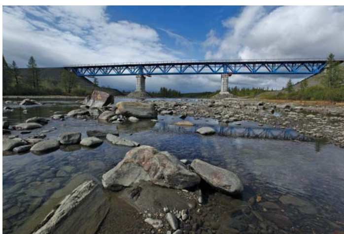
Jeden z mostów na linii Obskaja – Bowanienkowo (30.06.2009 r.) Fot. Gazprom
