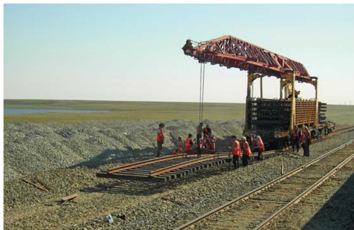
Układanie toru na stacji Pajuta (5.07.2007 r.)
