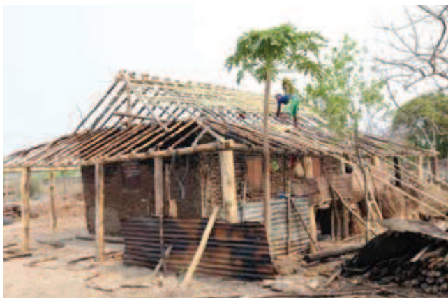
Rys. 4. Budynek z dachem parasolowym w trakcie budowy (Wyżyna Centralna na Madagaskarze) [1]
