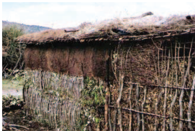
Rys. 2. Jednym z etapów budowy jest wyplecenie przy użyciu cienkich elastycznych gałązek na elementach konstrukcyjnych budynku, siatki o wymiarach ok. 10 cm w pionie i ok. 1–2 cm w poziomie [1]
