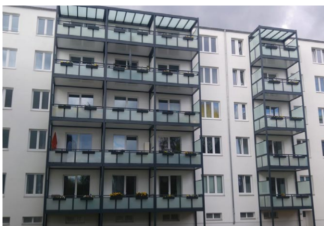
Rys. 6. Widok balkonów o konstrukcji dostawnej do budynku. Materiały przedsiębiorstwa Copal Sp. z o.o.
