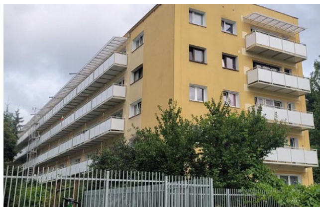
Rys. 7. Widok balkonów podwieszanych o konstrukcji stalowej z podłogą z płyty kompozytowej. Materiały przedsiębiorstwa Balkon Plus Sp. z o.o.
