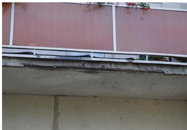
Rys. 3. Widok typowego uszkodzenia konstrukcji loggii w budynku wykonanym w systemie Szczecińskim, Poznań 2021 r.
