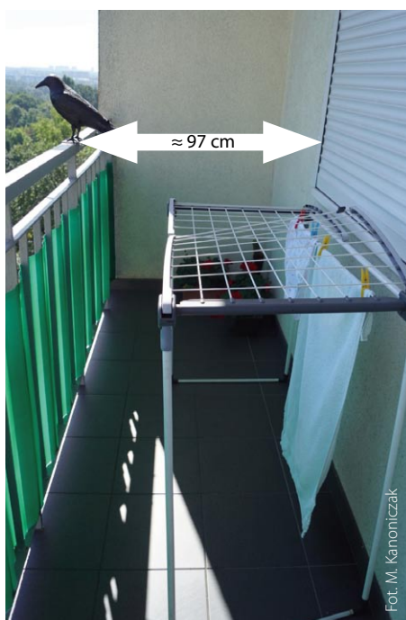
Rys. 4. Widok loggii ze zmniejszoną szerokością użytkową na skutek docieplenia ściany zewnętrznej budynku. System Szczeciński, Poznań 2023 r.
