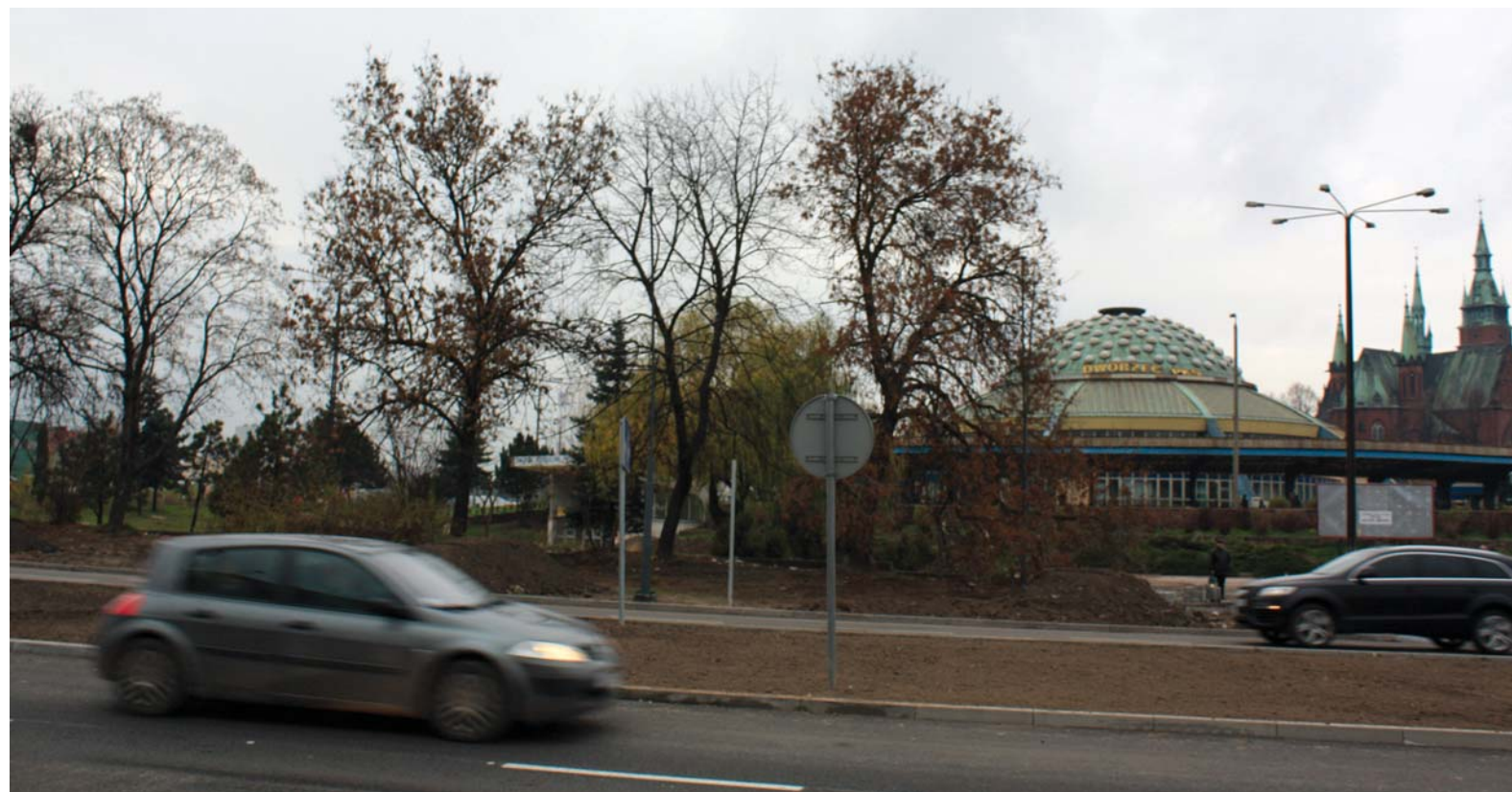
il. 7. Dworzec autobusowy, stan obecny. Fot. Edyta Banachowska, listopad 2014 / Kielce Bus Station, the current state. Phot. Edyta Banachowska, November 2014
