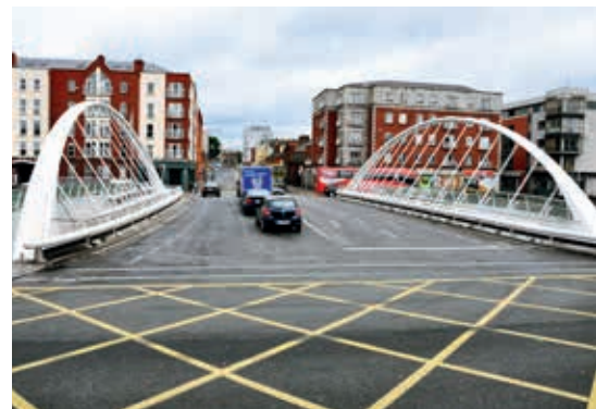
Ryc. 3. James Joyce Bridge w Dublinie (obiekt nr 50)
