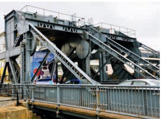
Ryc. 11. Scherzer Rolling Lift Bridges w Dublinie (obiekt nr 55)
