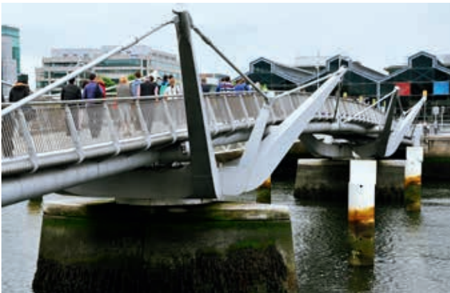
Ryc. 15. Sean O'Casey Bridge w Dublinie (obiekt nr 58)
