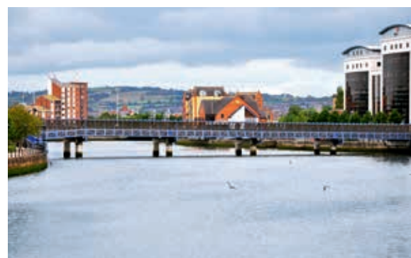
Ryc. 31. Kryty, stalowy most dla pieszych przez rzekę Lagan w Belfaście (obiekt nr 70)
