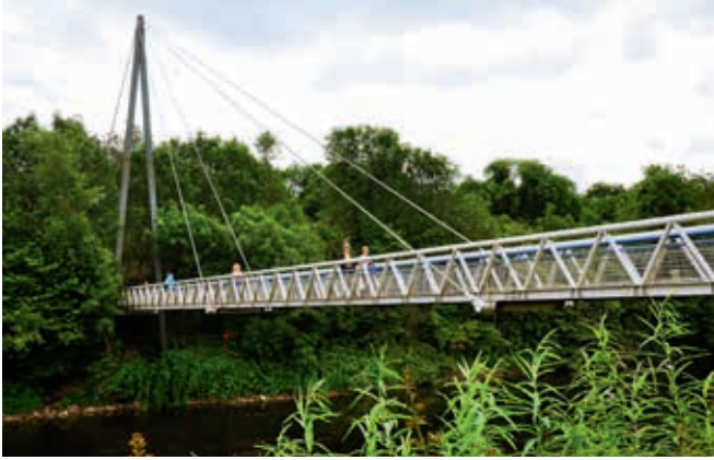
Ryc. 21. Most podwieszony dla pieszych przez rzekę Boyne (obiekt nr 62)
