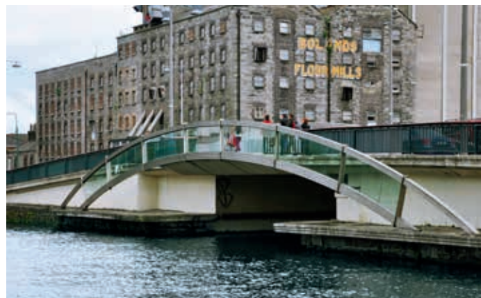
Ryc. 13. MacMahon Bridge w Dublinie (obiekt nr 57)
