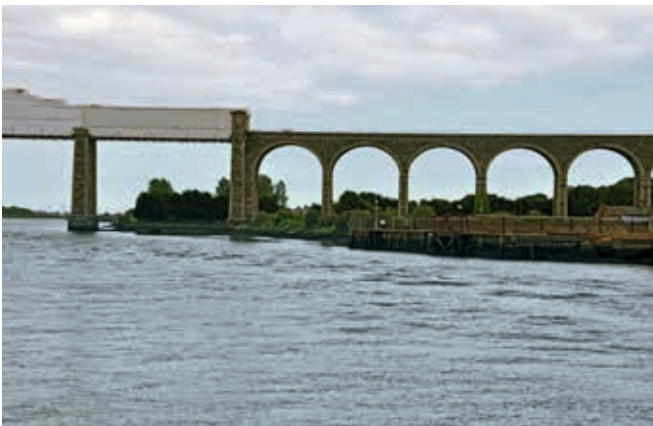
Ryc. 23. Wiadukt i most kolejowy przez rzekę Boyne w Drogheda (obiekt nr 64)
