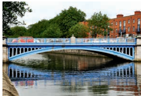
Ryc. 5. Rory O'More Bridge w Dublinie (obiekt nr 51)
