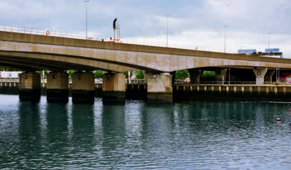
Ryc. 28. Sześcioprzęsłowy, betonowy most belkowy, sprężony, przez rzekę Lagan w Belfaście (obiekt nr 67)
