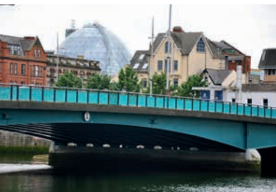
Ryc. 29. Queen Elizabeth Bridge w Belfaście (obiekt nr 68)
