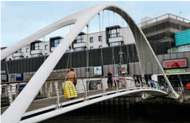
Ryc. 22. Scotch Hall Footbridge przez rzekę Boyne w Drogheda (obiekt nr 63)
