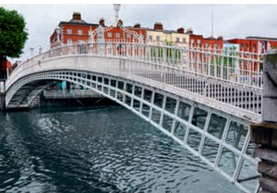
Ryc. 1. Liffey Bridge w Dublinie (obiekt nr 47)
