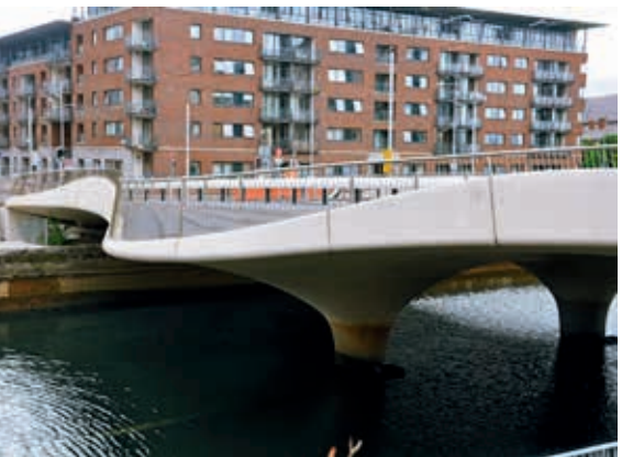
Ryc. 10. Spencer Dock Bridge w Dublinie (obiekt nr 54)
