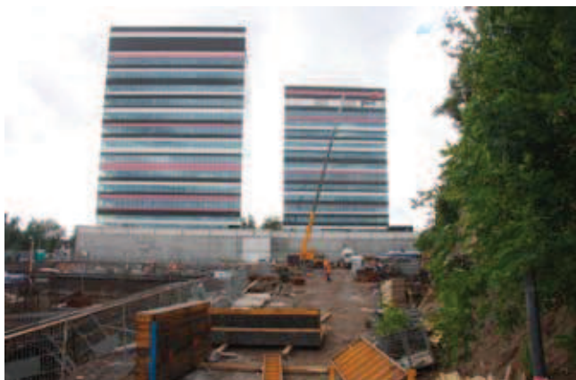
Rys. 4a. Widok zespołu budynków biurowych
