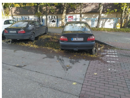
Fot. 8. Brak ścieków przykrawężnikowych w obrębie przejścia (fotografia – zasoby własne autorek)
