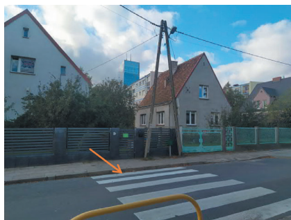
Fot. 6. Brak rampy na przejściu dla pieszych (fotografia – zasoby własne autorek)
