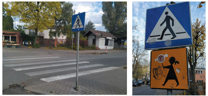
Fot. 2. Zły stan oznakowania poziomego oraz brak urządzeń dla osób niewidzących i niedowidzących (fotografia – zasoby własne autorek)
