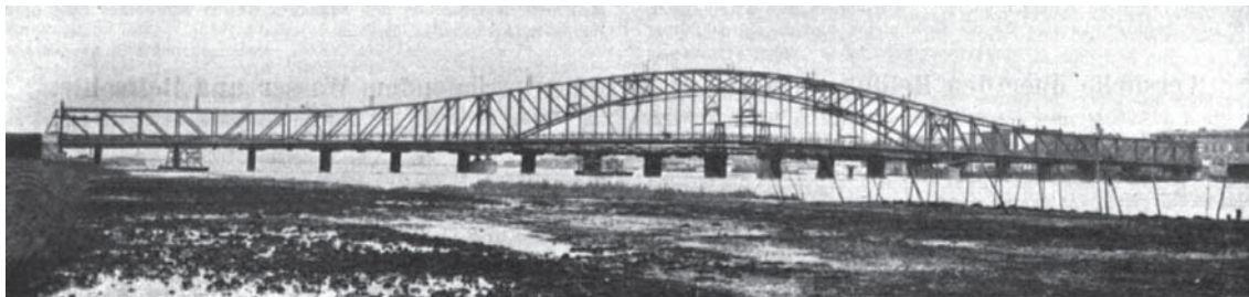
Fot. 8. Widok ogólny mostu koło Greifenhagen po ukończeniu jego budowy [4]
