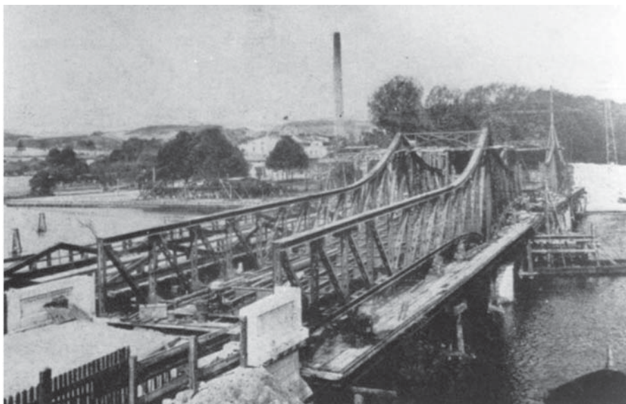
Fot. 11. Montaż stalowej konstrukcji mostu koło Mescherin (źródło: Biblioteka Publiczna w Gryfinie)
