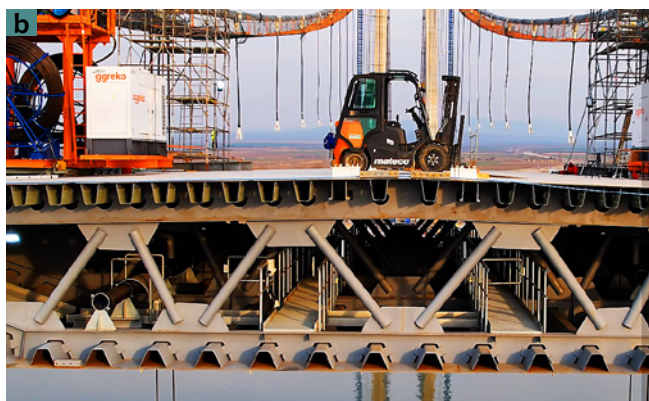
Ryc. 5a, 5b. Transport i montaż sekcji pomostu, YouTube, zdjęcie z drona, autor Raducu P. Drum
