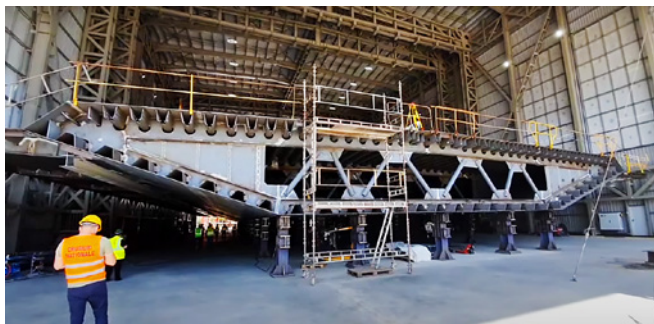
Ryc. 4. Prefabrykacja sekcji pomostu w stoczni Vard w Brăiili, YouTube, zdjęcie z drona, autor Raducu P. Drum
