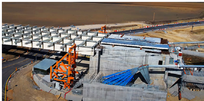
Ryc. 6. Kotwienie lin nośnych od strony Brăiili, YouTube, zdjęcie z drona, autor Raducu P. Drum
