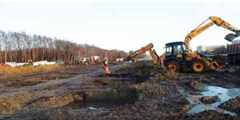
Rozpoczęcie budowy – likwidacja starego układu torowego na stacji Łódź Widzew
