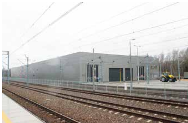
Hala przeglądowo-naprawcza po oddaniu do eksploatacji. Fot. A.Massel
