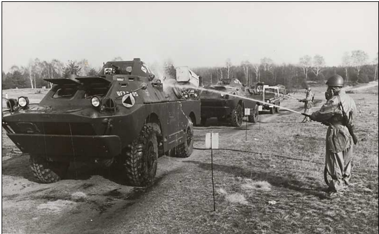
Fot. 6. Po wykonaniu zadania przez pododdział ppor. Romana Mazarskiego w terenie skażonym opancerzone samochody rozpoznawcze BRDM-2 poddano dezaktywacji. W II poł. XX w. bardzo obawiano się i przygotowywano do działań w warunkach użycia broni masowego rażenia. BRDM-2 zostały wyposażone w urządzenia pozwalające na działania bojowe w takich warunkach.
