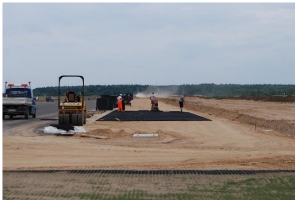
Rys. 9. Układanie kraty lotniskowej na odpowiednio przygotowanych warstwach konstrukcyjnych
