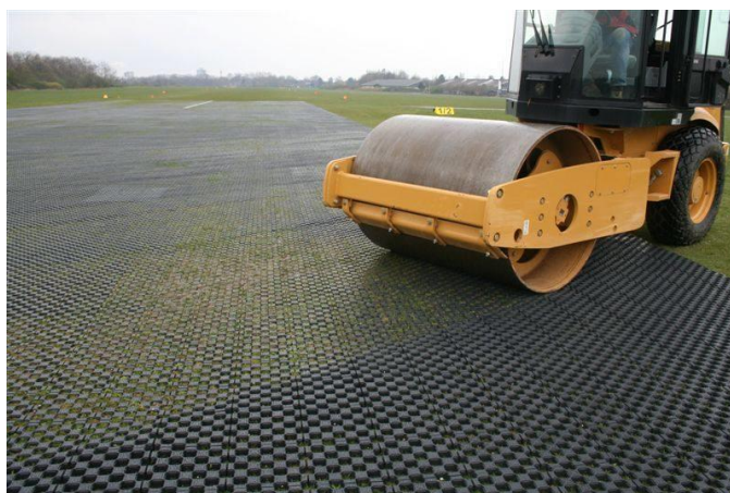
Rys. 12. Wciskanie kraty lotniskowej w nawierzchnię naturalną za pomocą walca
