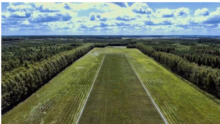
Rys. 10. Utwardzona za pomocą kraty trawiasta nawierzchnia drogi startowej [ https://www.geoproduct.pl/realizacja/trawiasty-pas-startowy/ ]
