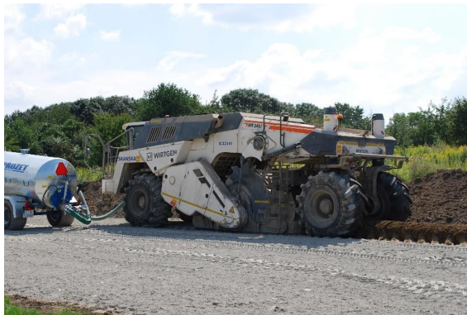
Rys. 6. Proces mieszania gruntu rodzimego ze środkiem chemicznym
