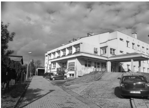
Il. 4. Widok na przychodnię od ulicy Szpunara, fot. K. Machalski.
