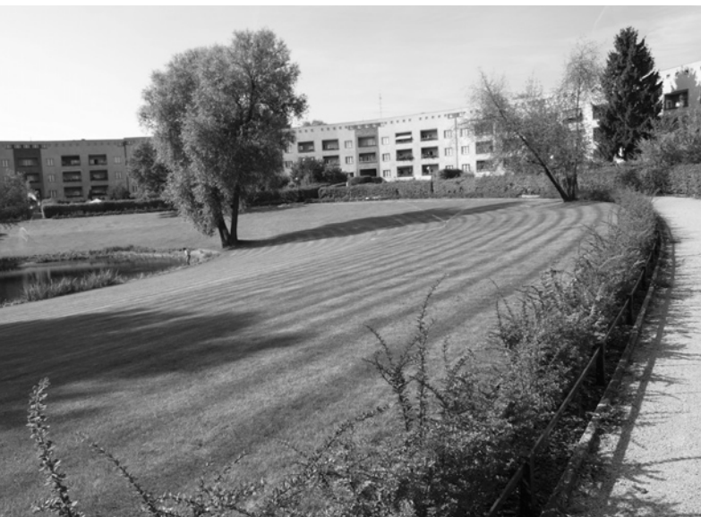
Ryc. 3. Owalny dziedziniec wewnątrz budynku-podkowy; fot. W. Niebrzydowski
