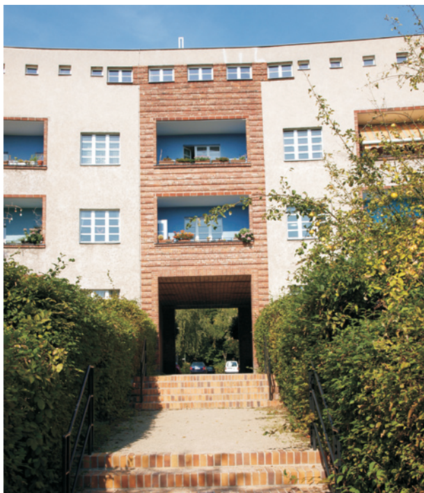
Ryc. 8. Przejście bramowe w budynku-podkowie zaakcentowane klinkierem; fot. W. Niebrzydowski
