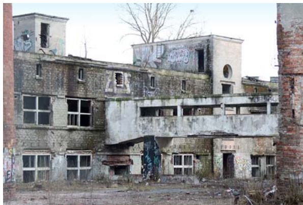
Ryc. 11. Elewacja frontowa budynku produkcyjnego, segment środkowy – stan obecny (fot. J. Dąbrowski)
