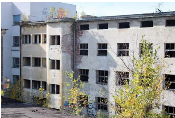
Ryc. 6. Elewacja tylna budynku biurowego – część południowa (fot. J. Dąbrowski)
