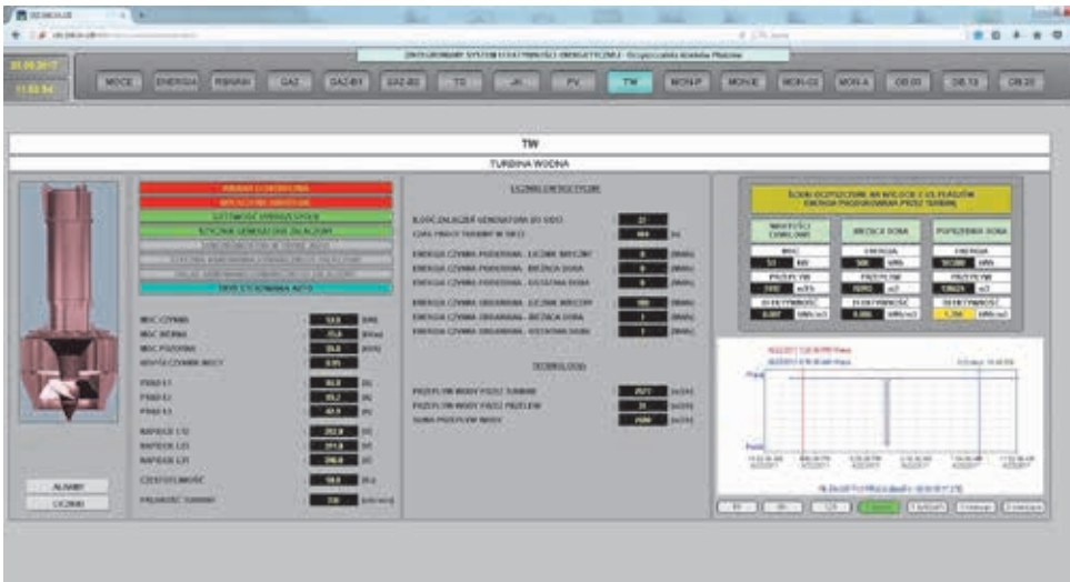
Ekran monitoringu turbiny na wylocie ścieków oczyszczonych w oczyszczalni Płaszów
