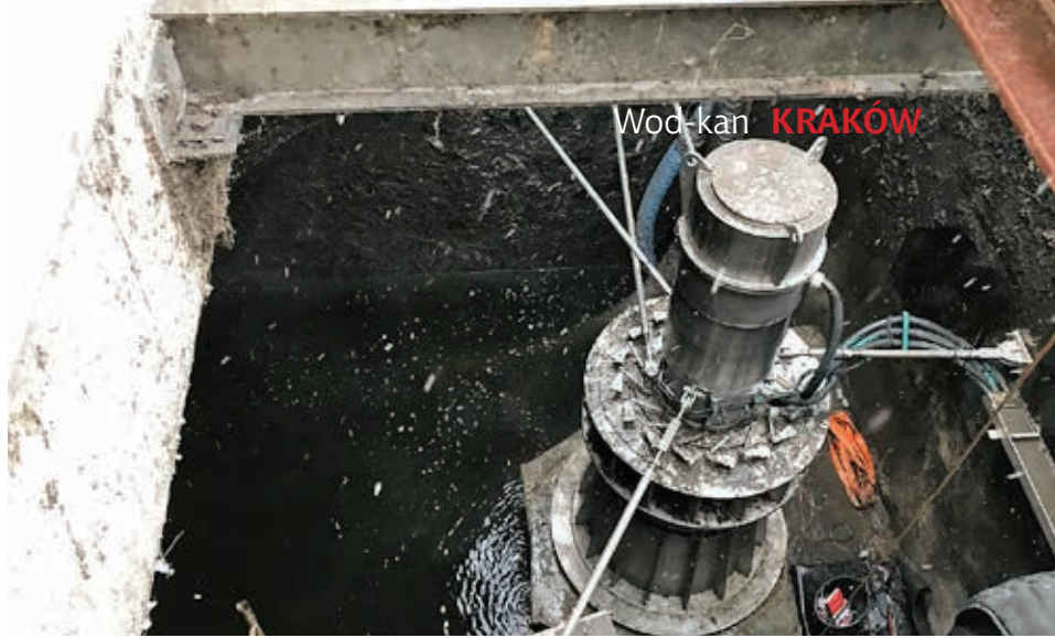
Widok turbiny Kaplana na wylocie ścieków oczyszczonych w trakcie prac przeglądowych
