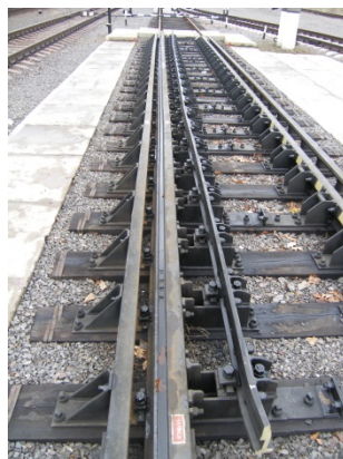
Rys. 3. Torowe stanowisko przestawcze systemu SUW 2000 [28]
