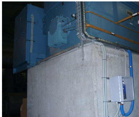
Rys. 1. System InsulGard firmy CUTLER-HAMMER do monitoringu stanu izolacji uzwojeń silników elektrycznych
