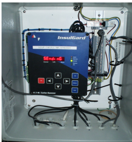
Rys. 3. Skrzynka zewnętrzna układu InsulGard do pomiarów wnz firmy CUTLER-HAMMER
