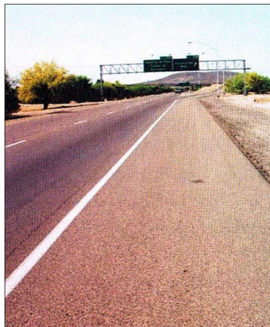
Rys. 12. Wygląd nawierzchni drogowej wykonanej z dodatkiem miazgi gumowego Fig. 12. The appearance of a road surface made with the addition of fine rubber
