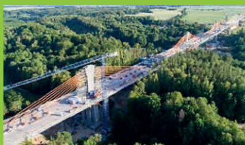
Most koło Ostródy w ciągu obwodnicy miasta (2017), L = 206,00 m
