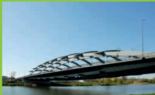
Most Kotlarski przez Wisłę w Krakowie (2001), L = 166,00 m
