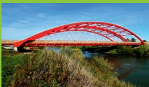
Most przez San w ciągu autostrady A4 (2013), L = 150,00 m
