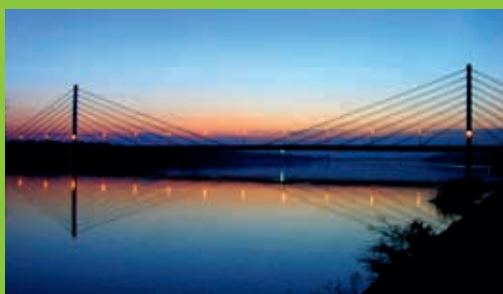
Most Solidarności przez Wisłę w Płocku (2005), L = 3750,00 m
