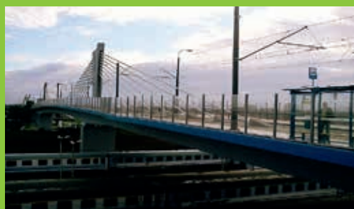
Estakada tramwajowa w Krakowie (2015), L = 126,00 m
