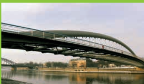
Kładka ojca Bernatka przez Wisłę w Krakowie (2010), L = 145,00 m
