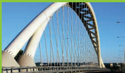
Wiadukt w ciągu Trasy Słowackiego w Gdańsku (2012), L = 120,00 m
