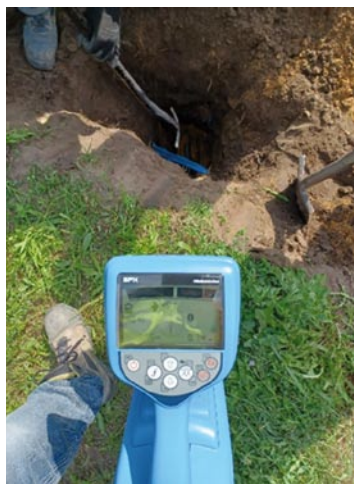
Rys. 9. Praca z lokalizatorem sieci podczas ręcznych przekopów kontrolnych
