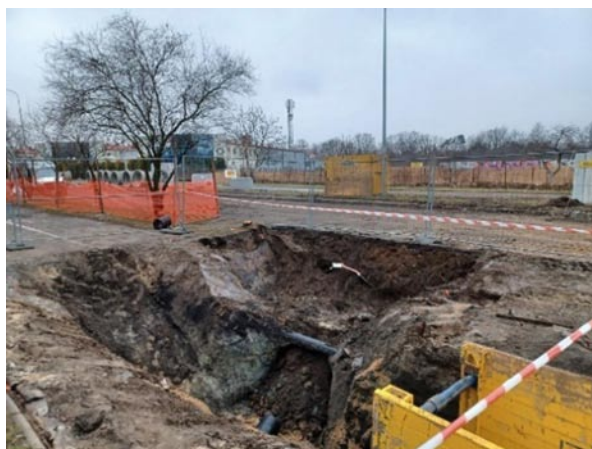
Rys. 5. Zdjęcia z miejsca uszkodzenia sieci nN
