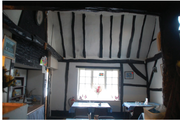
Il. 2. Dom M&S – elementy drewniane wewnątrz (fot. M.M. Kolakowski)
