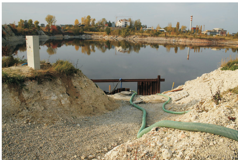
Fot. 1. Odpompowywanie odcieków ze zbiornika Górka (fot. Ł. Lelek 2012)
