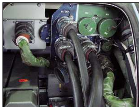
Fot. 10. Widok złączy kontrolnych układu IKW-8 dla sygnałów pomiarowych [7]
