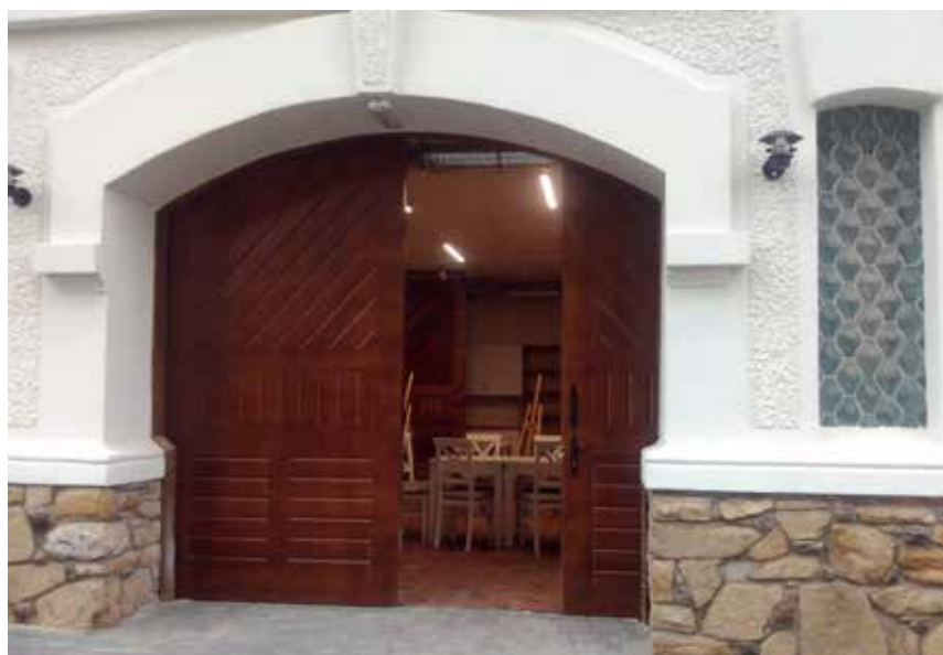
Fot. 4. Dom administratora ze stajniami, po modernizacji. Nowe wrota do stajni. Widok z 2021 r.; źródło: fot. aut.
