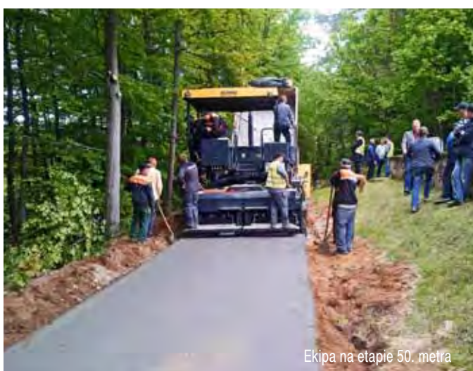
Układanie pierwszego metra betonowej drogi
